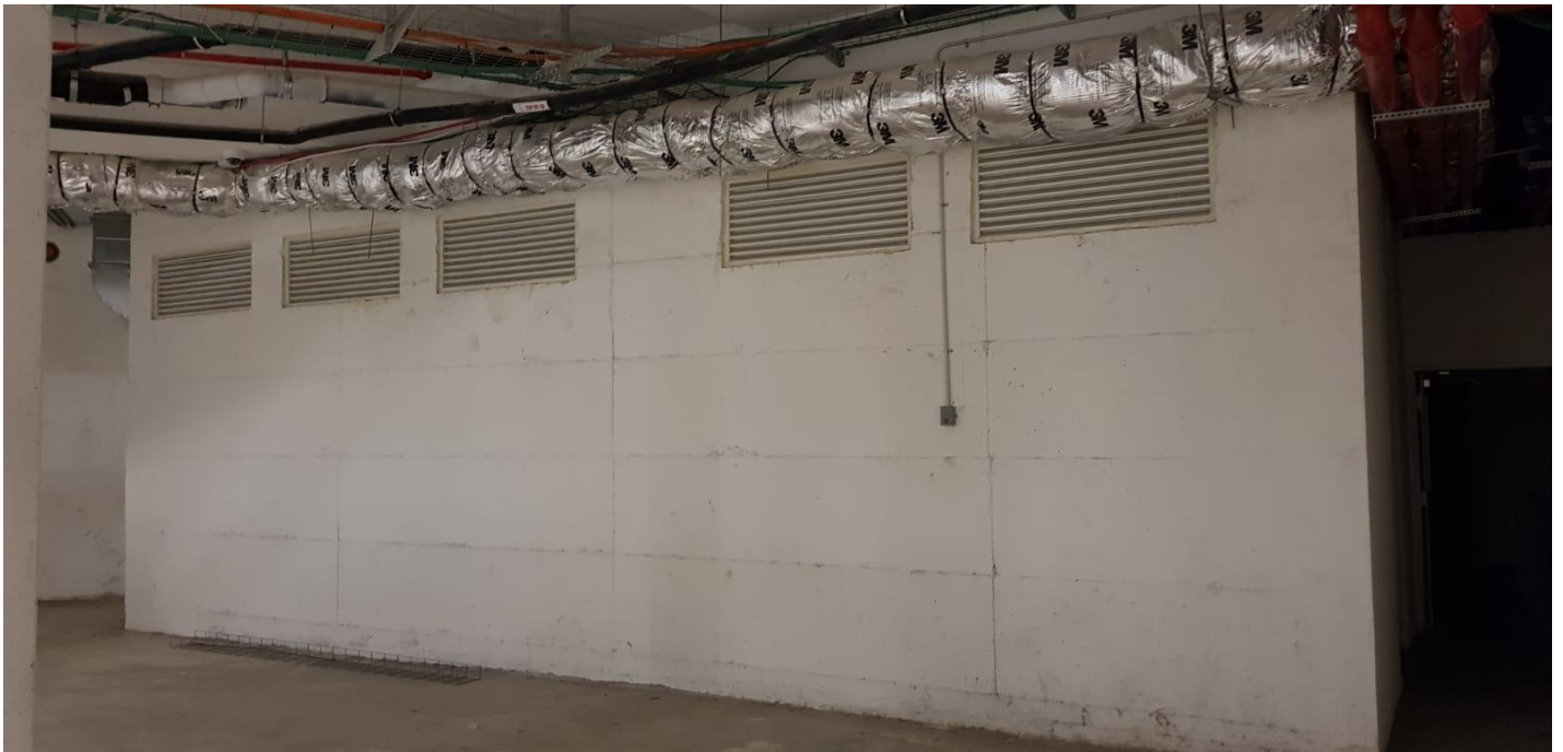
תמונה מס' 24: שחרור עשן מהמחסנים בחניון מתבצע באופן טבעי אל החניון ומהחניון באמצעות מפוחים.
