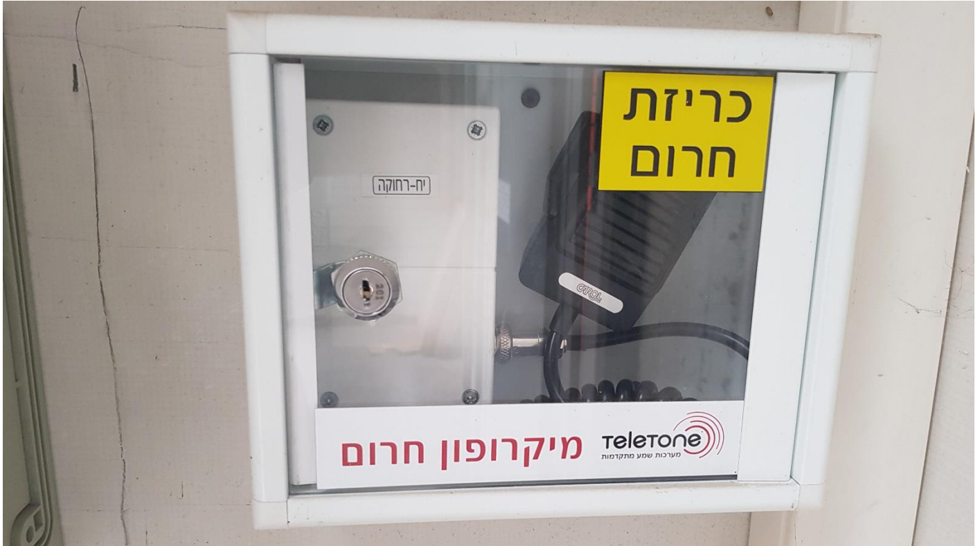
תמונה מס' 34: מערכת כריזה לכל המבנה ממוקמת בפאנל כבאים בקומת קרקע.
