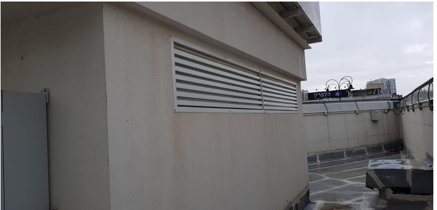
תמונה מס' 26: שחרור עשן מחדר מדרגות מתבצע באופן טבעי ע"י 2 פתחים הממוקמים בצמוד לתקרה.
