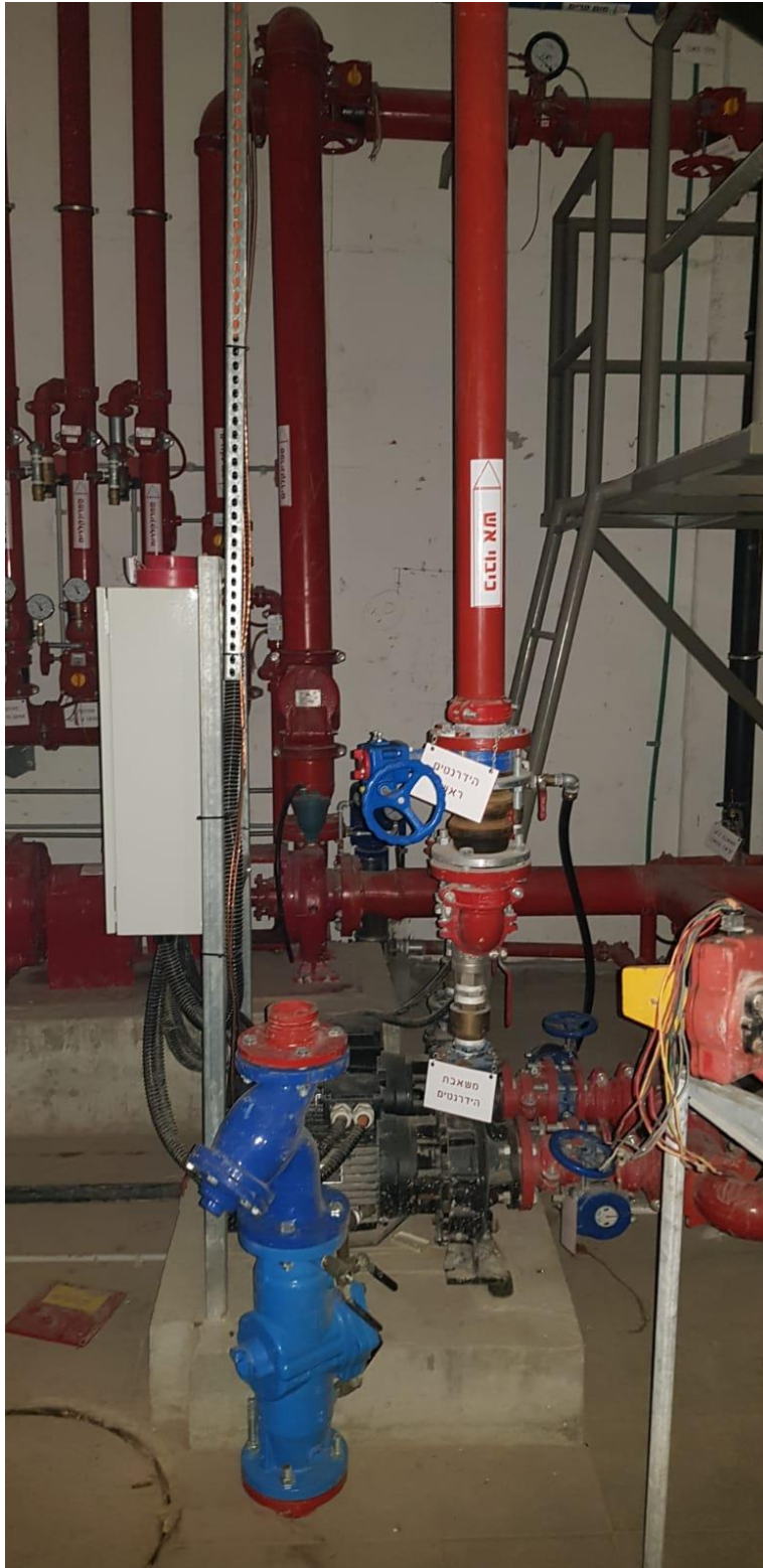
תמונה מס' 16: ברז מתזים ראשי ממוקם בחדר משאבות בקומת החניון.
