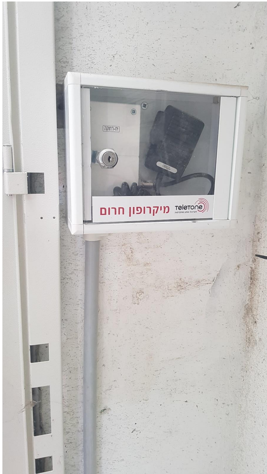
תמונה מס' 35: מיקרופון כריזה ממוקם סמוך לכניסות במבנה.
