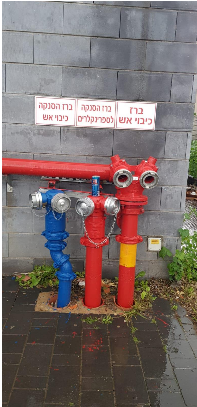
תמונה מס' 7: ברז כיבוי אש "2*3" כפול סמוך לברז מים ראשי.
