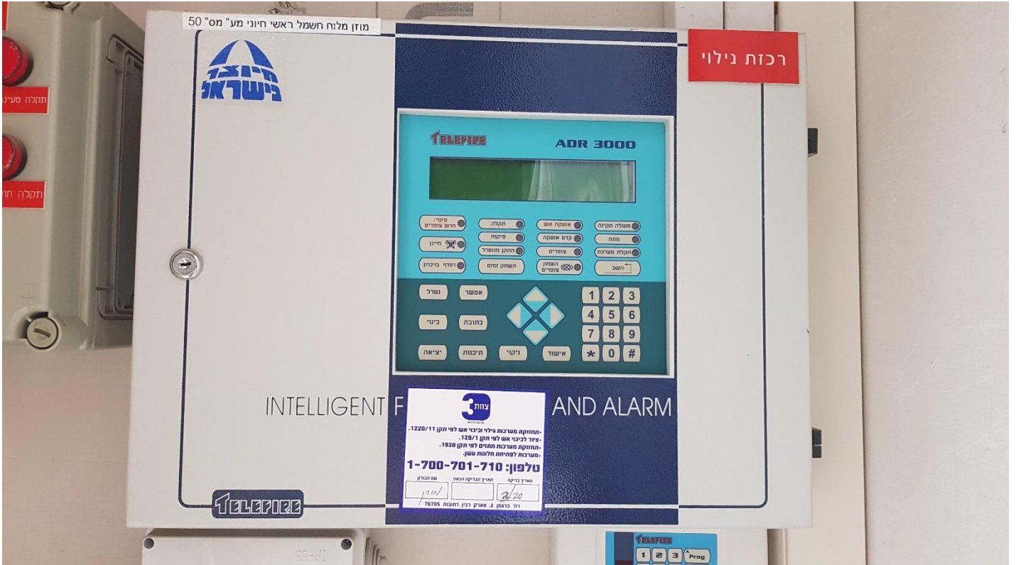
תמונה מס' 22: רכזת ראשית ממוקמת בקומת קרקע בכניסה הראשית למבנה בתוך ארון פאנל כבאים.
